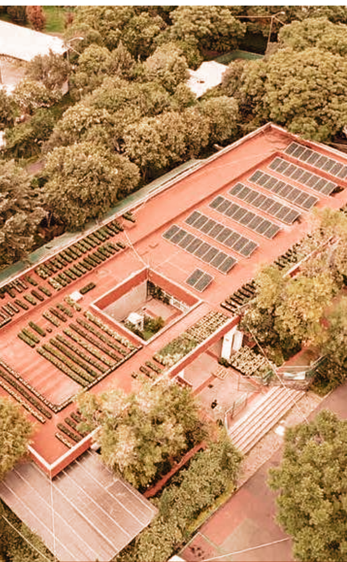
SISTEMA FOTOVOLTAICO, ALCALDÍA ÁLVARO OBREGÓN.
